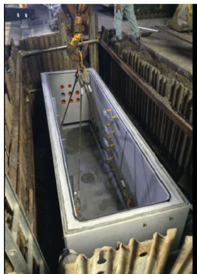
③中間ブロック据付け
