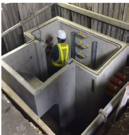
⑤ 親機・子機連結ボルト締め
