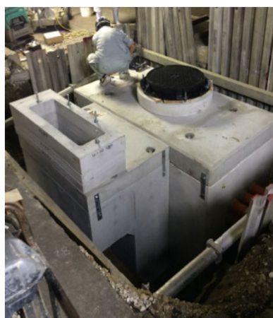
⑦ 調整部材・鉄蓋 組上げ
