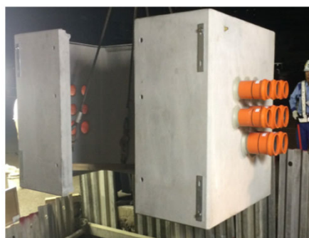
② 親機中間ブロック据付け
