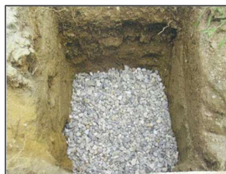
碎石基礎敷設
