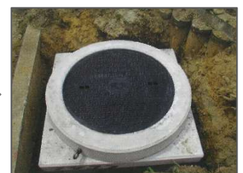
⑬据付完了
