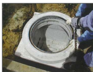
⑫蓋受け据付
